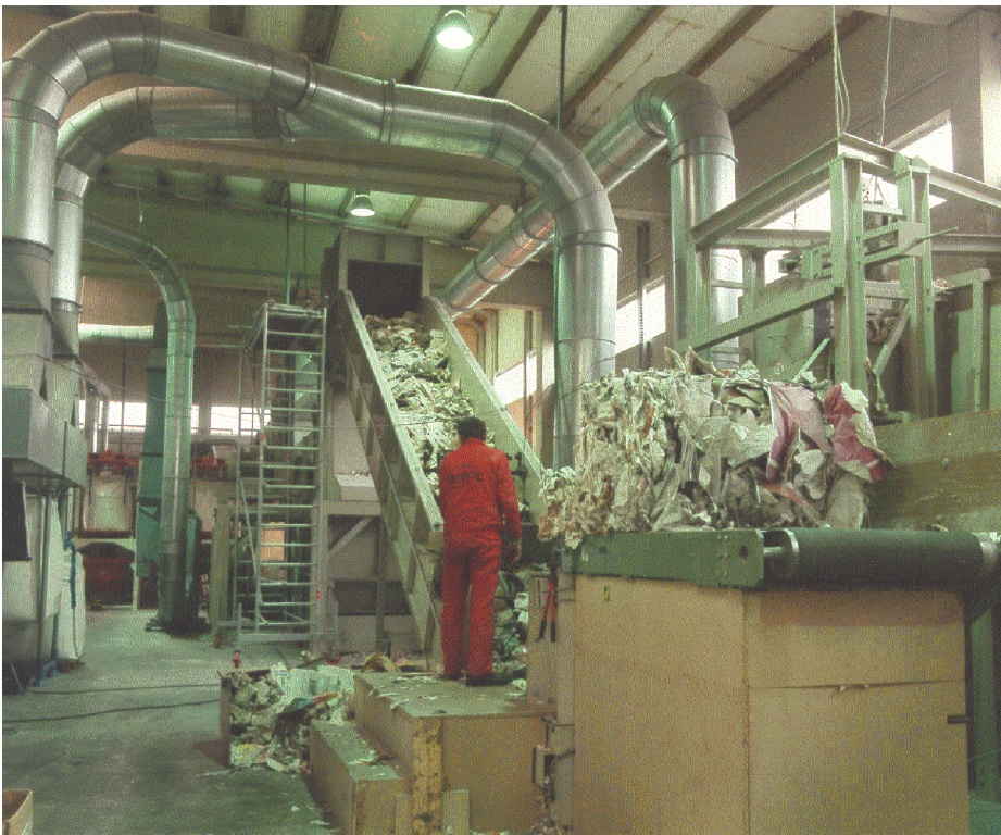
Abbildung 6.2: Foto einer Produktionsanlage der Firma ISOFLOC
